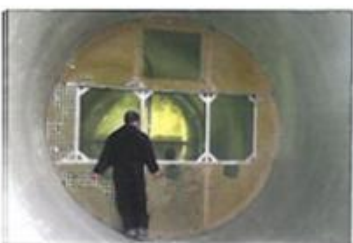
高强度，长期耐腐蚀维修平台与筒体寿命一致（50年）
