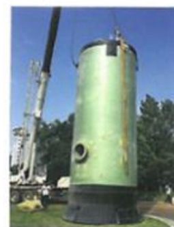
采用吊装施工快速便捷
