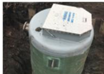
泵站顶盖采用高强GRP成型可拆装设计
